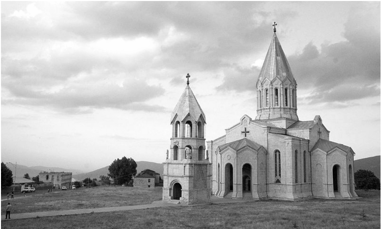
Церковь Газанчецоц Сурб Аменапркич (Всеспасителя) после реставрации
